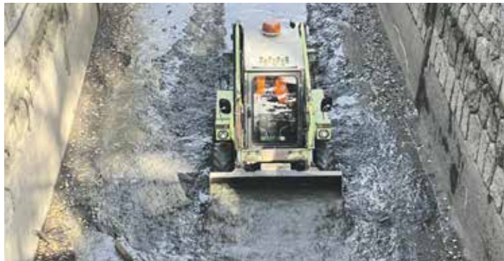
Opravy plavebních komor mají zajistit plynulost a spolehlivost dopravy. Foto | Povodí Moravy
