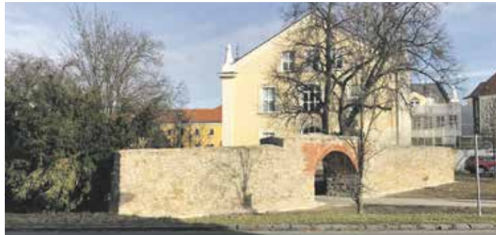
Památka vyžadovala obnovu kvůli destruktivním účinkům vlhkosti. Foto | město Uherské Hradiště
