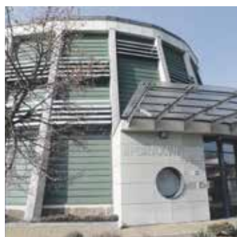
Halu před třemi lety citelně poškodilo tornádo. Foto | Mapy.cz
