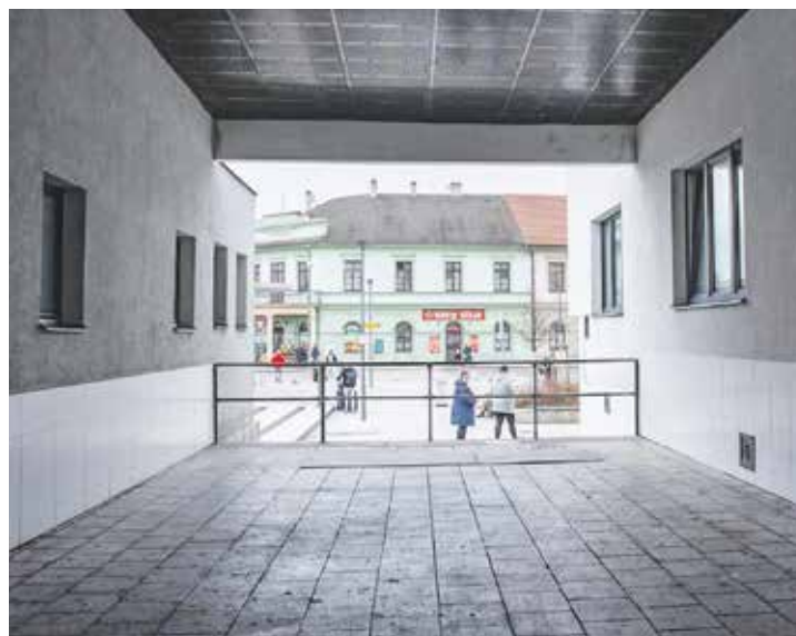
Přestavbou podchodu se stane kolínské nádraží plně bezbariérové. Foto | město Kolín
