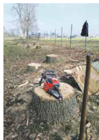
Město muselo nechat vykácet přestálé dřeviny, na jejich místě zasadí odborníci více než dvě stě stromů.
