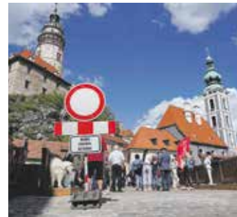
Omezení na mostě mělo původně trvat 6 měsíců, nakonec se podařilo zprovoznit most pro pěší za 3,5 měsíce. Foto | město Český Krumlov
