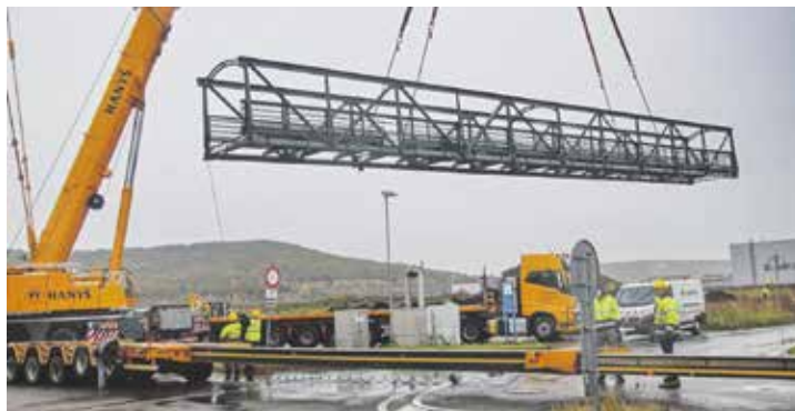
Část lávky váží 110 tun a dostat ji do Boleslavi byl spontánní nápad tehdejšího primátora Nwelatiho. Díky tomu neskončí ve šrotu, ale opět poslouží. Foto | město Mladá Boleslav
