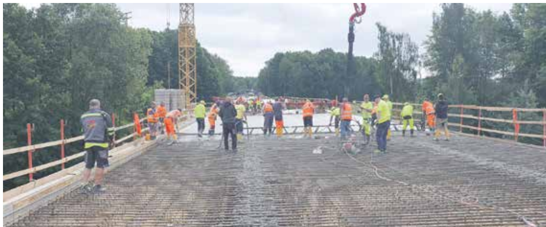
Na vybetonování posledního mostového pole v délce zhruba 40 metrů padlo na 250 kubických metrů betonu. Foto | město Mnichovo Hradiště
