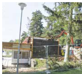
Demoliční práce začaly v srpnu poté, co dosavadní provozovatel ukončil činnost a vyklidil objekt.
