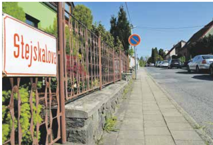
Jednosměrná ulice má za sebou opravu plynovodu, vodovodu i kanalizace. Do listopadu dostane nový povrch. Foto | město Vyškov
