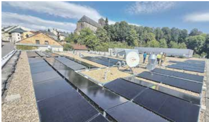
Letos město nechalo osadit střechy fotovoltaickými panely první městské budovy. Foto | město Turnov
