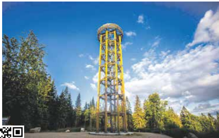
Rozhledna má výšku 21 metrů a postavena byla v roce 2021. Foto | TIC Jablonec
