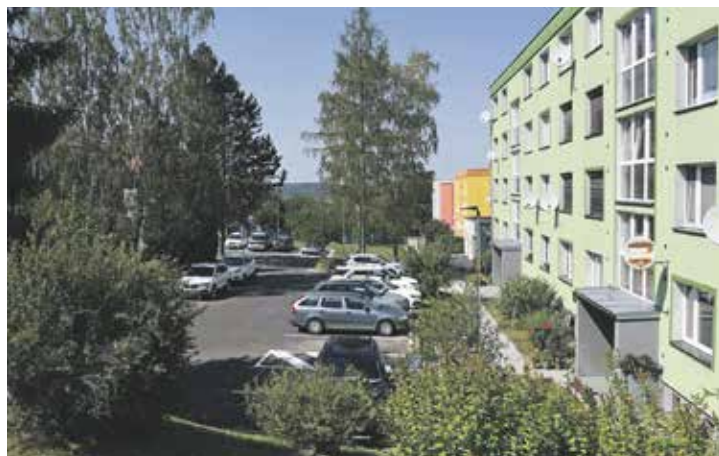
Za regeneraci panelových sídlišť město zaplatilo už téměř čtvrt miliardy korun. Foto | město Valašské Meziříčí
