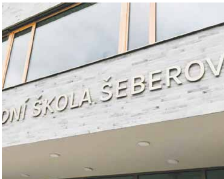
Nová základní škola byla postavena v reakci na demografický růst. Foto | MHMP
