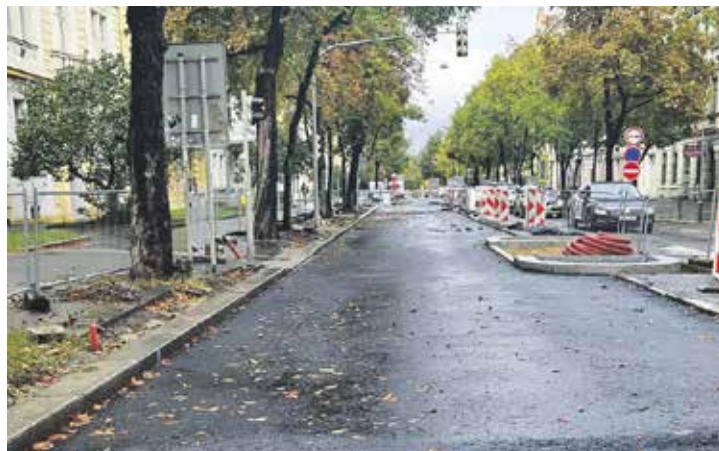
Důvodem rekonstrukce je vysoké stáří vodovodních řadů, které byly vybudovány v letech 1940–1975. Foto | TSK
