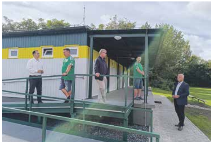
Nové kontejnerové kabiny nabízejí zázemí hráčům, rozhodčím i divákům. Foto | město Nymburk
