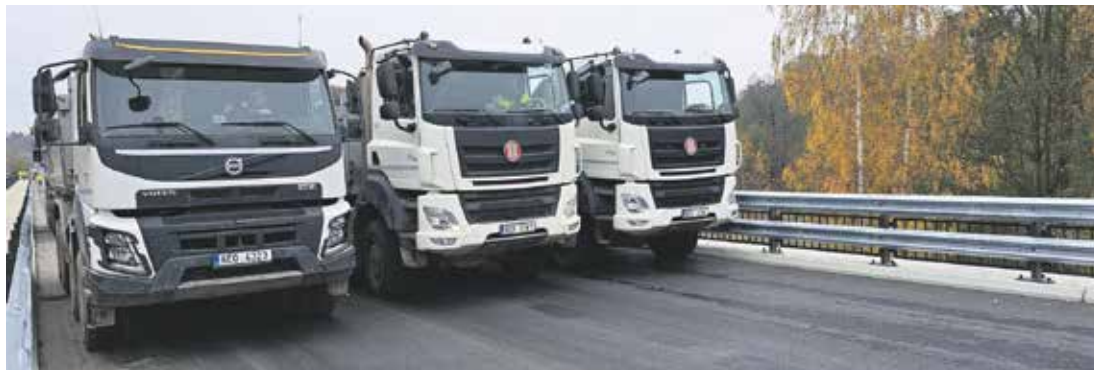
Na novém mostě se konala i jeho zátěžová zkouška, jeho otevření tak už nic nebrání. Foto | město Mnichovo Hradiště
