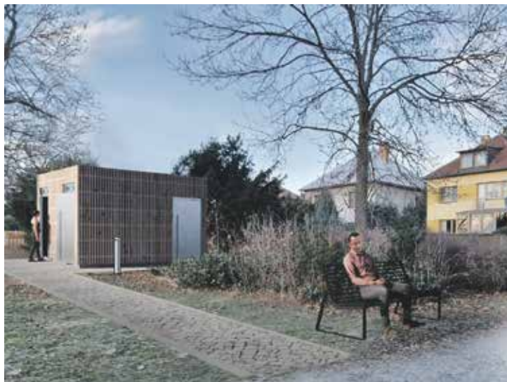
Toalety budou v blízkosti křižovatky ulic Fričovy a Sadové, která je zhruba uprostřed sadů. Je zde také jeden ze vstupů do parku a dětské hřiště. Foto | město Mělník
