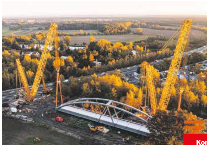
Nový most o hmotnosti 400 tun přesouvaly na místo speciální těžké jeřáby. Foto | Správa železnic
