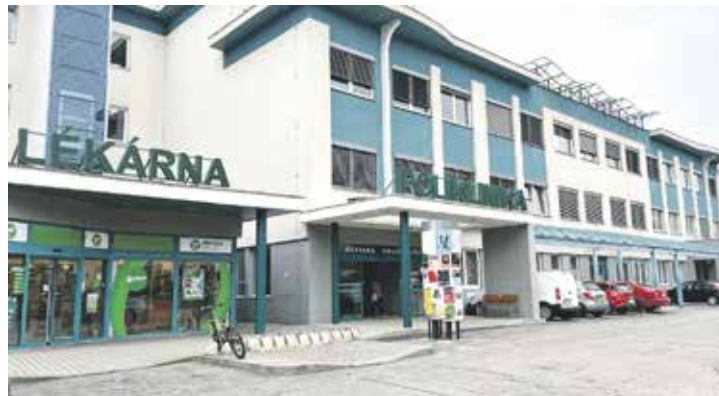
Osmá etapa rekonstrukce se týkala centrálního schodiště. Foto | město Rožnov pod Radhoštěm
