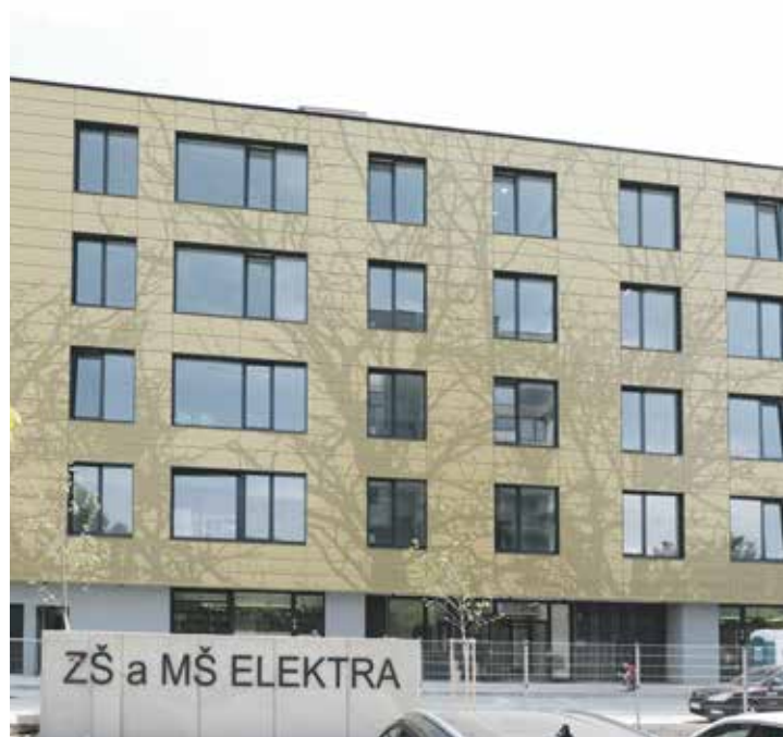
Základní a mateřská škola Elektra ve Vysočanech. Foto | mj
