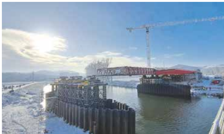
Vysouváný most je s rozpětím 115 metrů druhým největším na Moravě. Foto | město Napajedla
