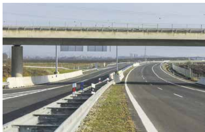
Zprovoznění nových úseků dálnice uleví lidem z okolních obcí. Foto | Zlínský kraj
