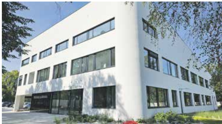
Nová poliklinika vznikla na místě bývalé mateřské školy v ul. Urxova, v sousedství budovy záchranné služby. Návrh připravilo architektonické studio Adam Rujbr Architects. Foto | město Neratovice
