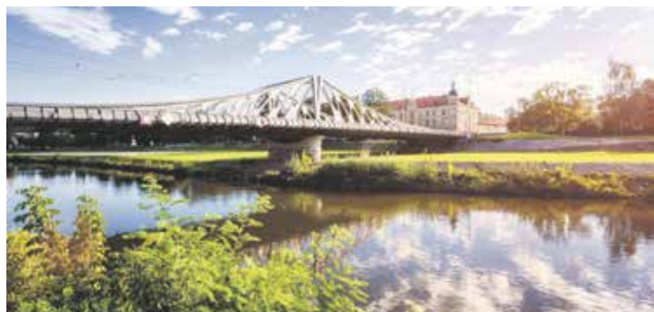
Visutý ocelový Dlouhý most slouží chodcům a řidičům od roku 1998, autorem návrhu je Roman Koucký. Foto | město České Budějovice
