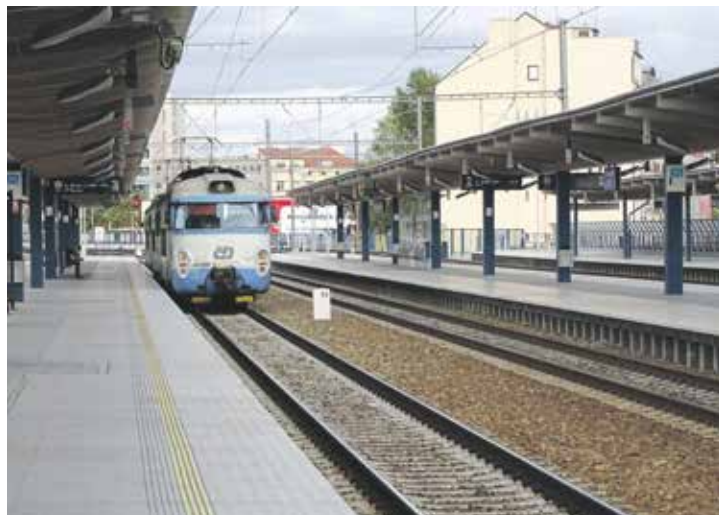
Stavba nové stanice Praha-Bubny omezí provoz vlaků. Foto | MČ Praha 7
