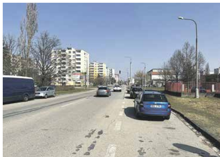
Po rekonstrukci poskytne ulice více parkovacích míst, podélná stání se změní na kolmá. Foto | Jihočeský kraj
