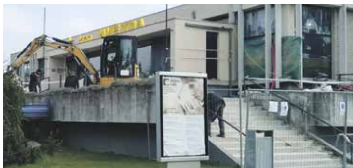
Opavy schodiště a ochozu mají být dokončeny do začátku letních prázdnin. Foto | Marek Adamík
