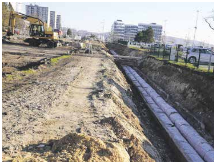
Stavbu mohou zkomplikovat nečekané události, jako třeba nutnost odstranit na stovkách metrů mohutnou vrstvu zeminy. Tu bude nutné nahradit v potřebném objemu odpovídajícími konstrukčními vrstvami pod vlastní komunikací. Foto | město Mladá Boleslav
