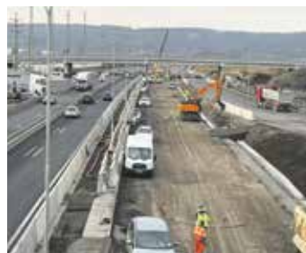
Stavba jede 7 dní v týdnu za plného nasazení dělníků. Provoz je zde veden ve dvou zúžených pruzích se sníženou rychlostí na 80 km/h. Foto | ŘSD
