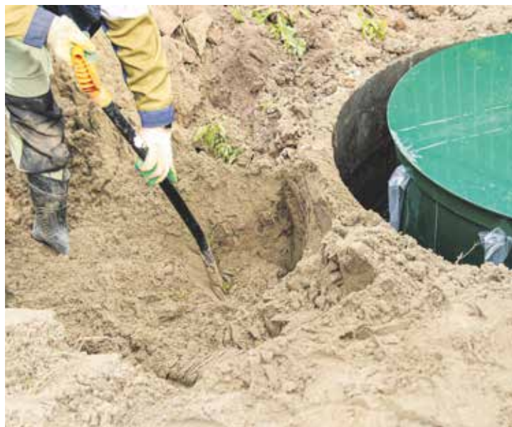
Soustavy moderních domovních čistíren jsou cenově efektivní a ekologicky přijatelná alternativa ke starým netěsným jímám či septikům, které bývají velkým zdrojem znečištění podzemních i povrchových vod. Ilustrační foto
