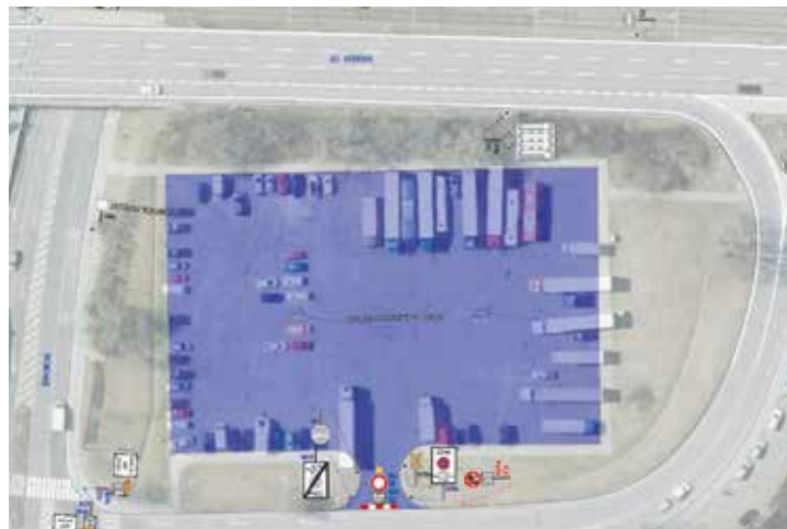
Parkoviště v ulici Bohunická se během probíhající rekonstrukce tramvajové trati proměnilo v zázemí staveniště. Foto | MČ Brno-Jih
