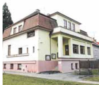
Dokončení renovace se předpokládá v první čtvrtině příštího roku.
