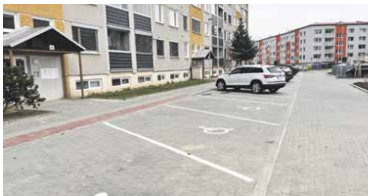
Parkoviště nyní disponuje 57 parkovacími místy. Foto | město Uherské Hradiště
