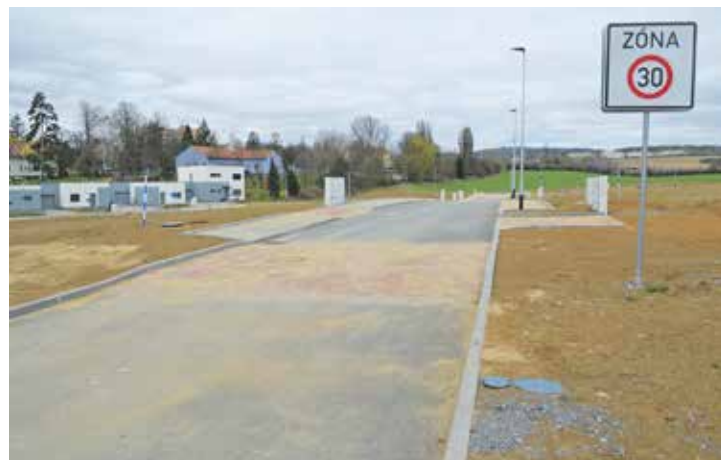
Lokalitu pro výstavbu nechalo město zasítovat a vybudovalo komunikace. Foto | město Vyškov
