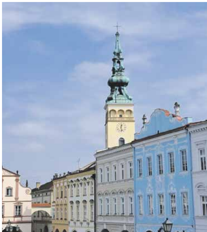
Věž byla postavena na konci 16. století. Foto | město Nový Jičín
