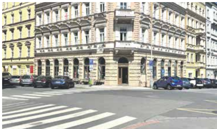
Opravy sítí zasáhnou Oveňskou, Přívozní i Tusarovu. Část křižovatek se uzavírá. Foto | Praha 7
