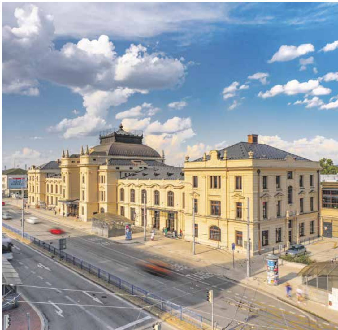
O cenu veřejnosti v kategorii Obnova památky bude bojovat i opravená nádražní budova v Českých Budějovicích. Foto | NPÚ
