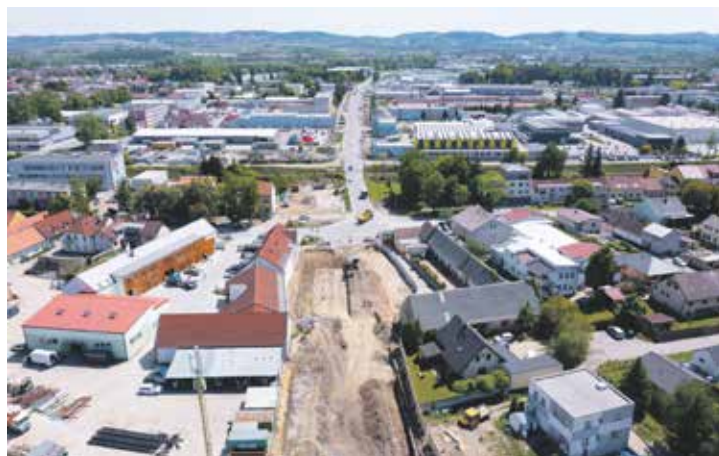
Severní spojce muselo ustoupit několik objektů, komunikace bude sloužit řidičům koncem roku 2027. Foto | ŘSD
