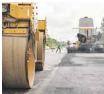
Stavební práce potrvají předběžně do 31. října. Foto | MČ Letňany
