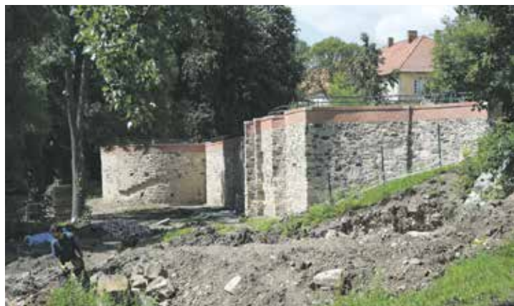
Oprava opěrných zdí v kosmonoském parku je jednou z částí revitalizace území. Město plánuje její dokončení do května příštího roku. Foto | město Mladá Boleslav
