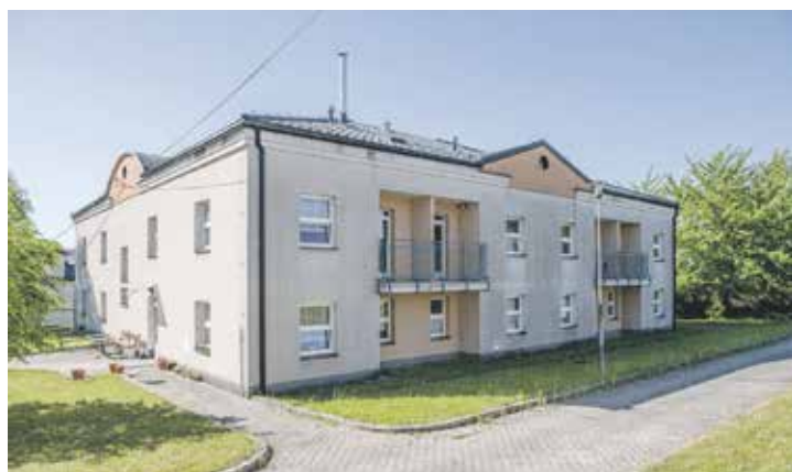
Rekonstrukce pavilonu K má být dokončena v dubnu 2026. Foto | město Kroměříž
