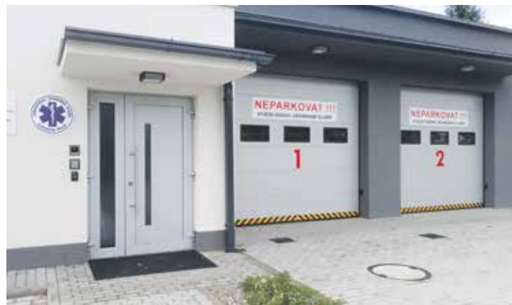
V budově základny se nachází garáž, dezinfekční zóna a dva sklady. Foto | Marek Adamík
