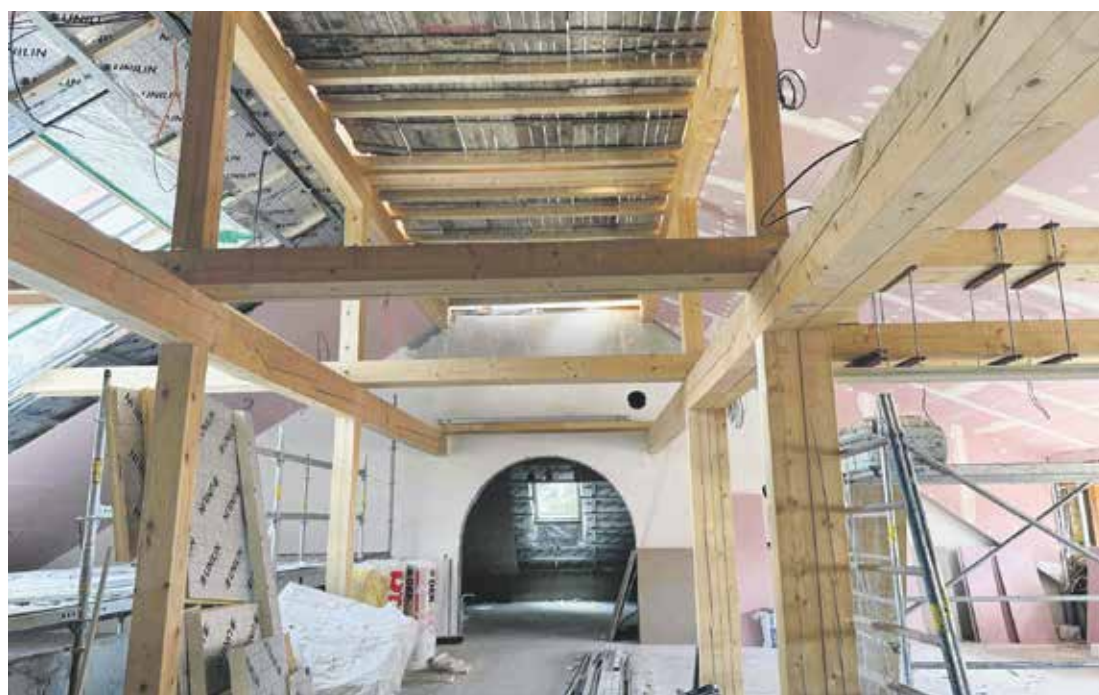
Kompletní obnova knihovny zahrnovala i novou střechu včetně krovů. Foto | město Jičín
