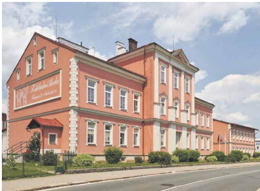
Tělocvična historické školy má díky novým oknům lepší prostředí a bezpečnostní skla. Foto | město Trutnov
