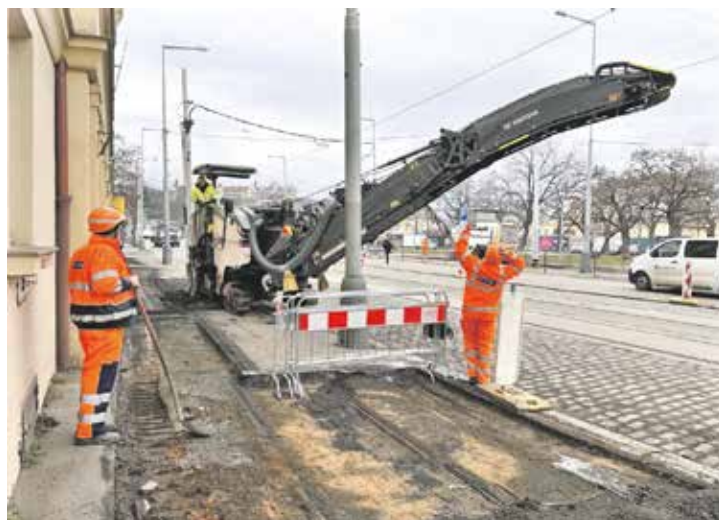
Na stavbu v ulici Výstaviště padl přes jeden kilometr kolejí. Foto | DPP
