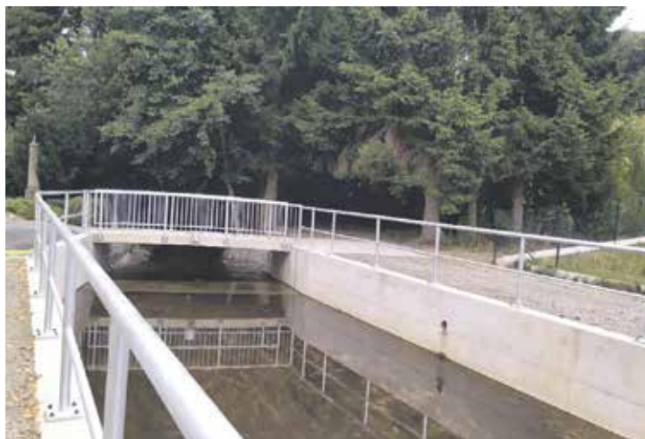
V rámci obnovy lávky došlo i k renovaci navazující požární nádrže. Foto | město Domažlice
