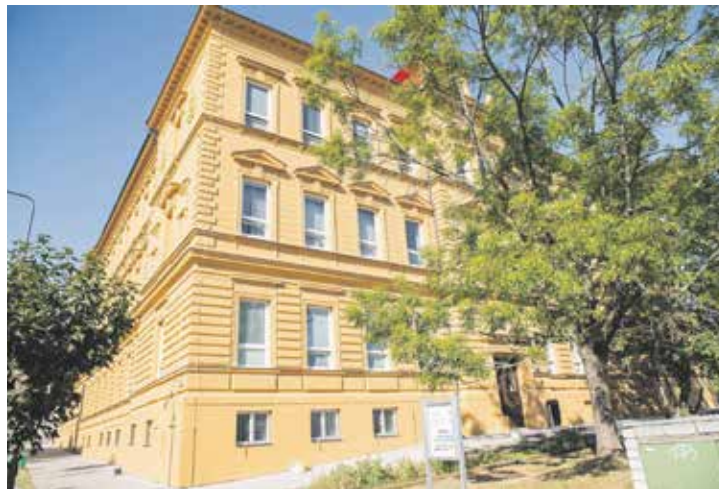
Kompletní rekonstrukce historické fasády trvala necelý rok, stavební firma ji stihla dokončit dva měsíce před termínem. Foto | město Kolín
