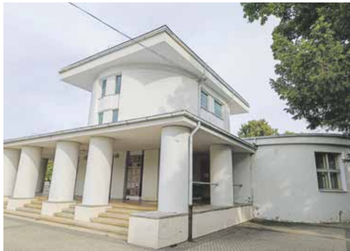
Nymburské krematorium bylo postaveno v letech 1922 až 1924 podle plánů architekta Bedřicha Feuersteina a Bohumila Slámy. Jedná se o první puristickou stavbu na území republiky. Foto | město Nymburk
