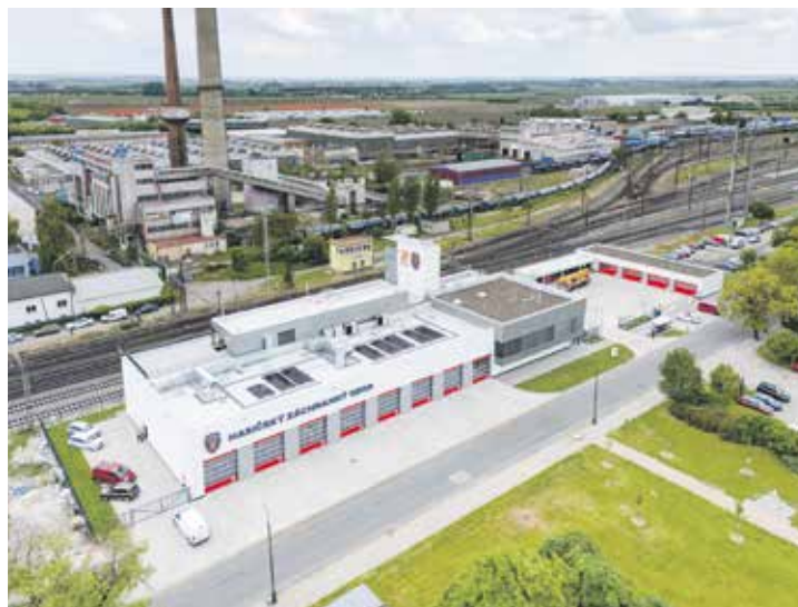
Moderní areál přesně odpovídá potřebám hasičů. Jednotlivé prostory, dílny a sklady odborných služeb, operační a informační středisko a hlavně důstojné zázemí pro hasiče na sebe plynule navazují.
