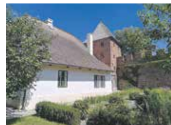
Rekonstrukce starého děkanství zahrnuje i opravu hradební věže Kaplanka. Foto | město Nymburk
