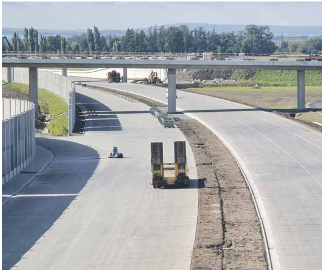
V polovině prosince začne řidičům sloužit desetikilometrový úsek dálnice D1 mezi Říkovcem a Přerovem. Je na něm 14 mostních objektů o délce 1900 metrů. Jedná se o poslední část dálnice která tak propojí Prahu, Brno a Ostravu. Foto | Juraj Aláč
