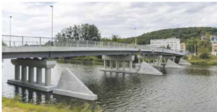
Most je už čtvrtou velkou mostní stavbou, kterou kraj během posledních let obnovil. Foto | Zlínský kraj
