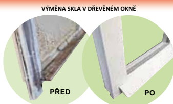
VÝMĚNA SKLA V DŘEVĚNÉM OKNĚ
