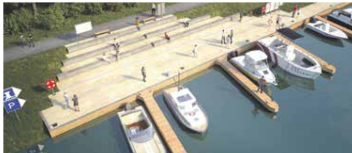
Součástí stavby přístaviště je vybudování pevného mola o délce 47 metrů. Foto | město Hodonín
