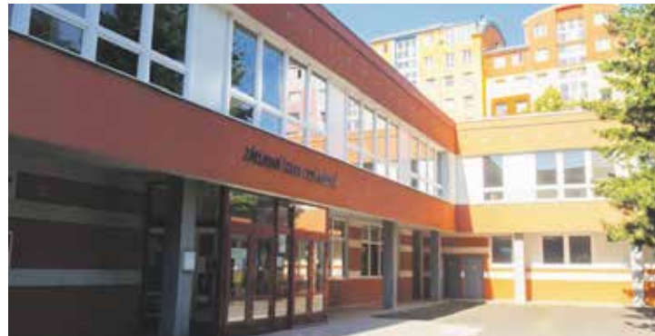
Jedním z větších letošních projektů bude vyhlášení veřejné zakázky na projektovou dokumentaci a následnou realizaci nástavby ZŠ Fryčovická. Foto | MČ Letňany
